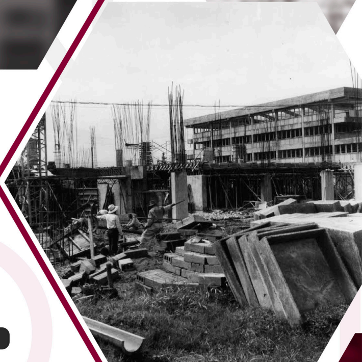
Construcción de la Facultad de Arquitectura.
